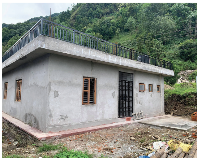
निर्माणाधिन वडा भवन वडा नं ७
