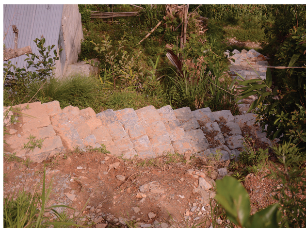
सिढी बाटो निर्माण वडा नं १
