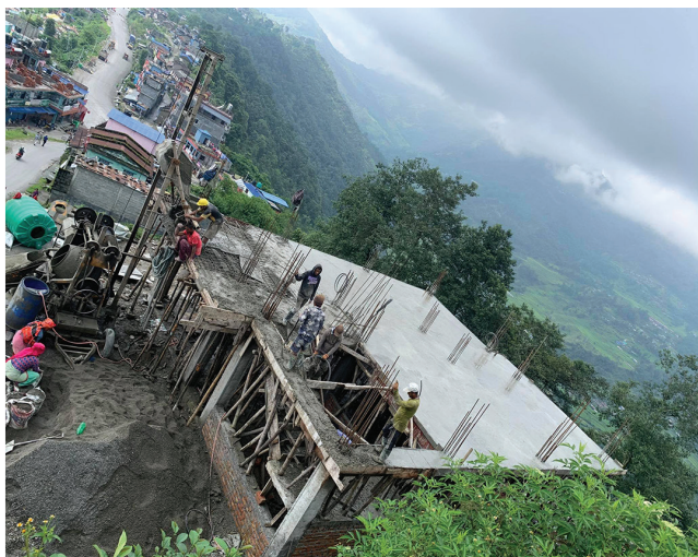
निर्माणाधिन वडा भवन वडा नं १
