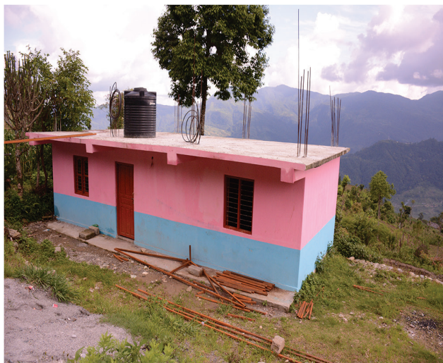
सामुदायीक भवन निर्माण फल्लापानी
