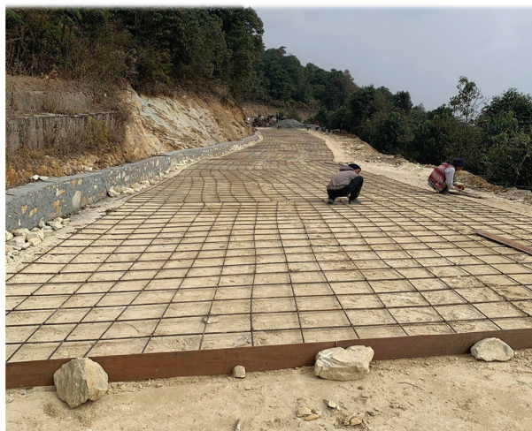
निर्माणधिन ढलानबाटो वडा नं ४
